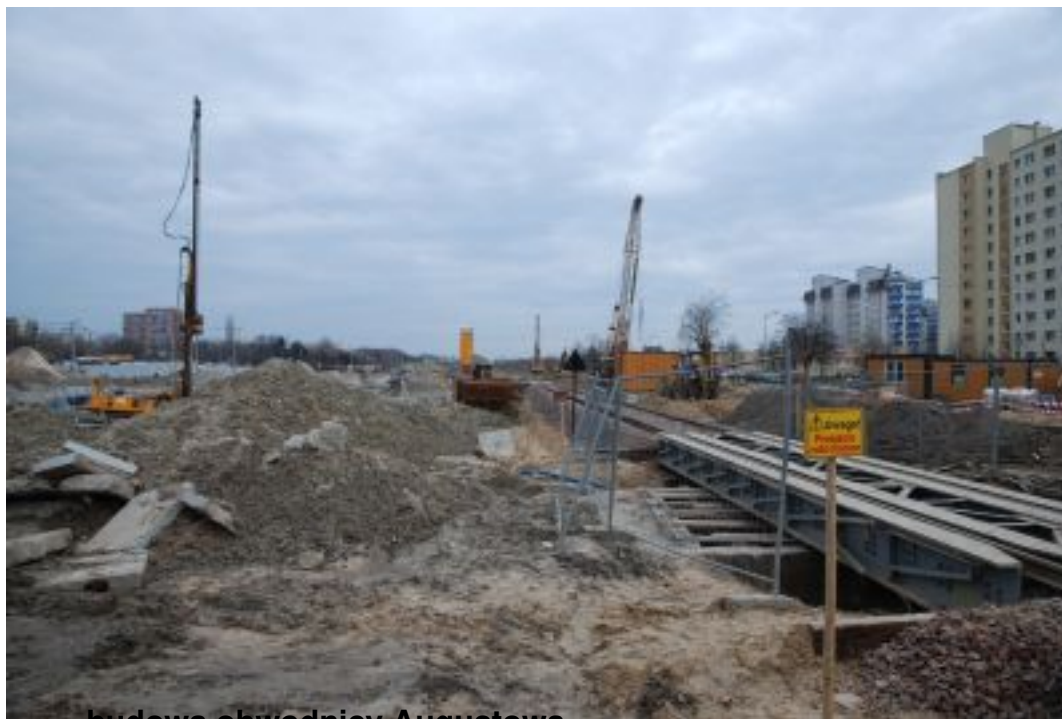
- budowa obwodnicy Augustowa
